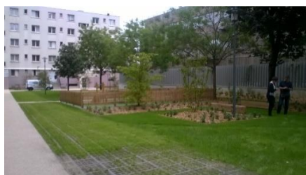
Dalles engazonnées, résidence Maryse Bastié (13 e )
